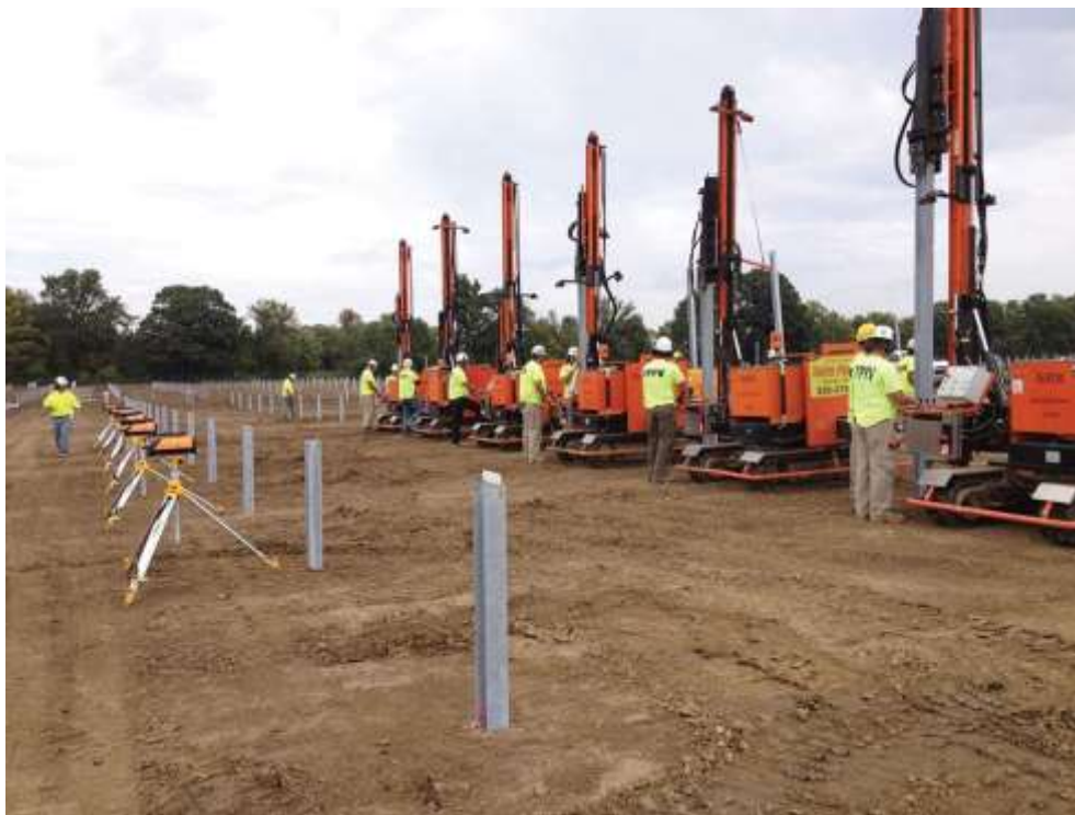
Слика 15. Приказ на машинерија за набивање на столбовите во земја
